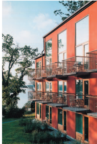
Utsikt över vattnet från flera av bostäderna. Ref. Nacka Strand, Hotel J. Arkitekt: Nyréns.
